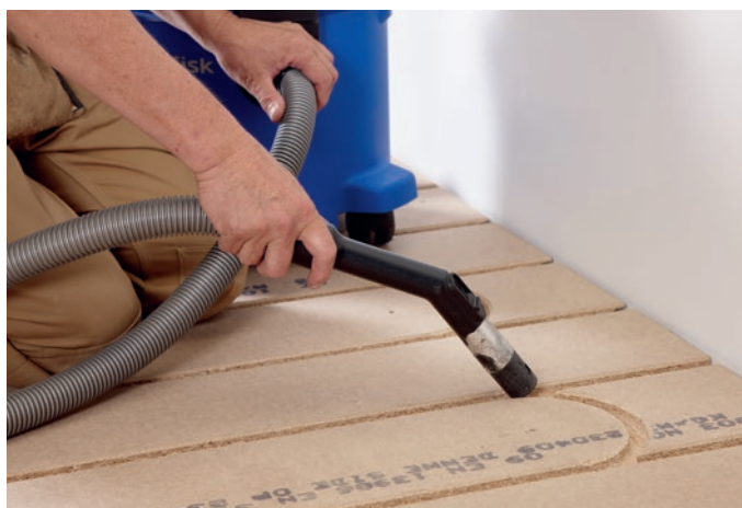
Figur 8 Omhyggelig rengøring forhindrer knirkelyde.
